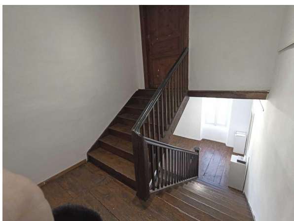
Palier 1er étage/2e étage
