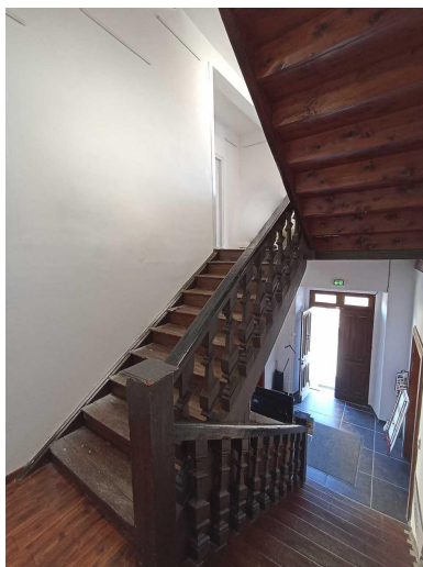
Palier RDC/1er étage
